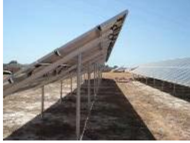
Şekil 2.9. Sabit Montaj Seti Uygulaması
