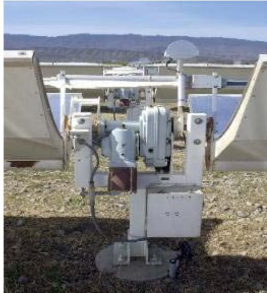
Şekil 2.22. İzleme Sisteminin Elektrik Motor – Şanzıman Kısmı
