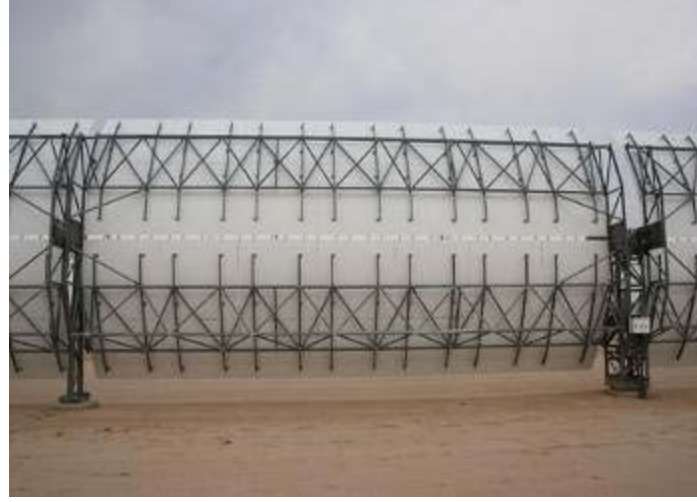
Şekil 2.21. CSP Montaj Seti
