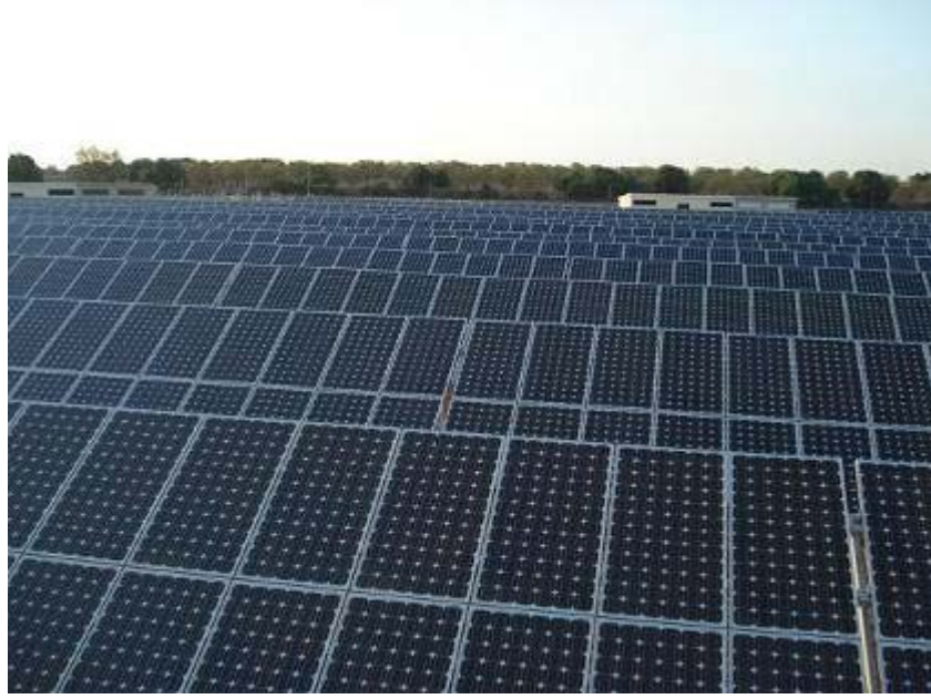
Şekil 2.13. 3 MW PV Santrali (Mallorca, İspanya)
