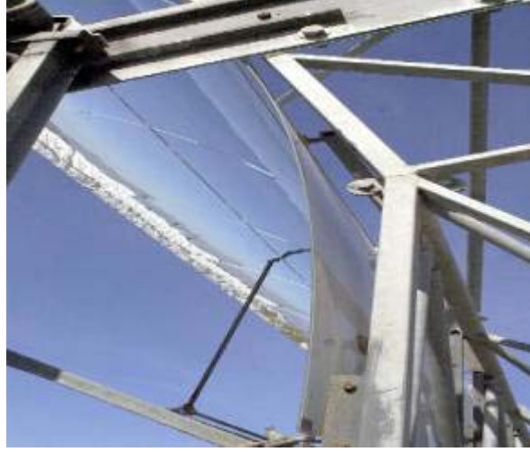
Şekil 2.19. 4 mm Kalınlığında CSP Aynası
